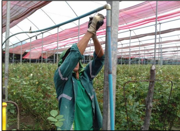
Figura 13: Troca da tubulação na estufa 12.
