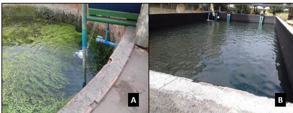
Figura 12: (A) Poços amazonas; (B) Tanques de captação de água.
