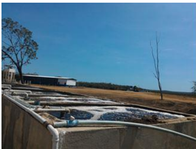
Figura 32 - Tanques de alvenaria para preparo de calda orgânica.
