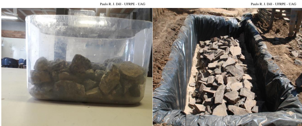
Figura 14 – Pote plástico com brita representando a etapa de alocação de pedras na construção da fossa ecológica. Figura 15 – Pedras alocadas dentro da fossa ecológica.
