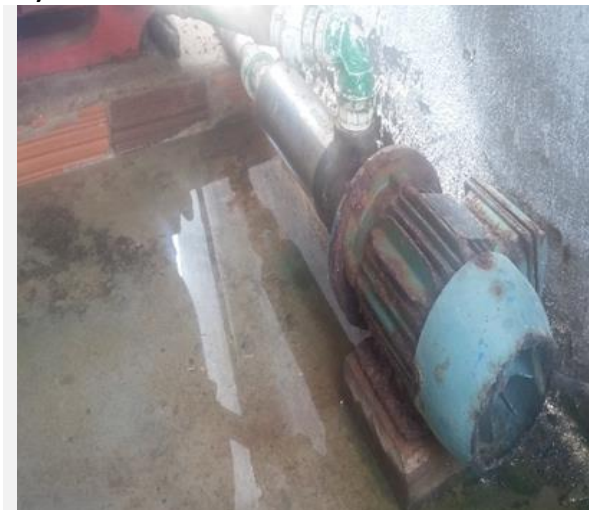
Figura 23 - Bomba injetora (A) e Tubo de Venturi utilizados na fertirrigação (B).
