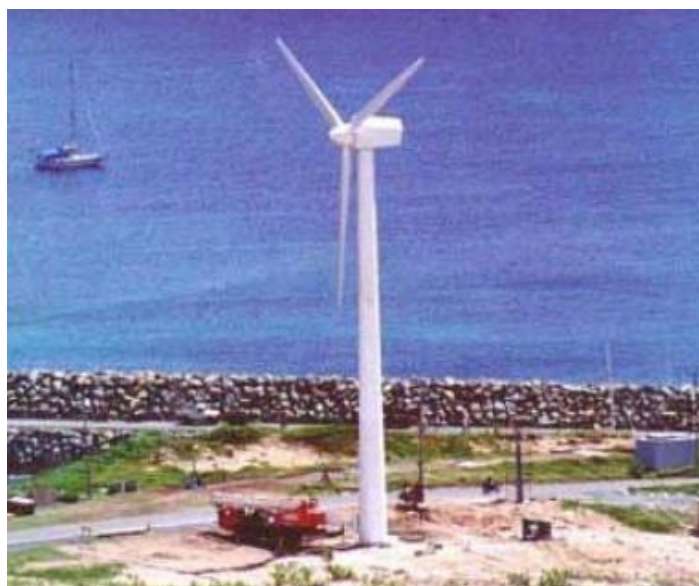
Figura 2 - Segundo aerogerador do Arquipélago de Fernando de Noronha.
