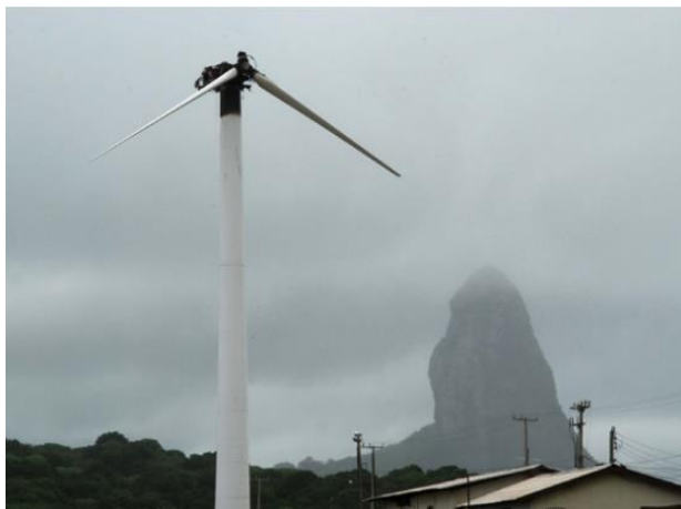
Figura 3 - Segundo aerogerador do Arquipélago de Fernando de Noronha atingido por um raio
