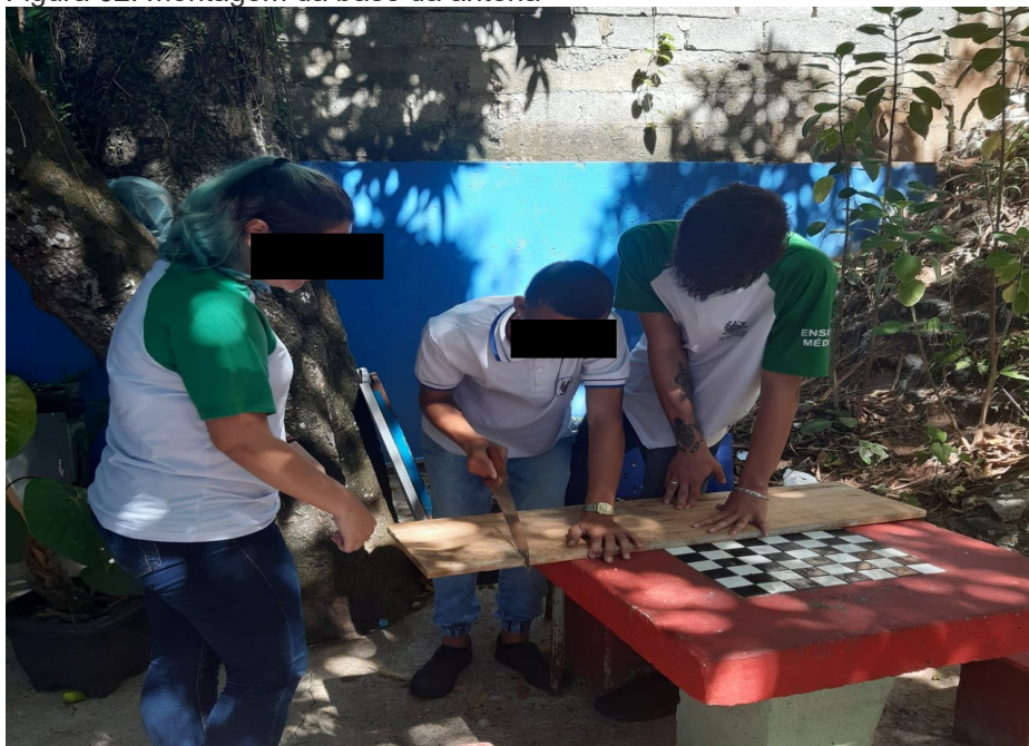
Figura 62: montagem da base da antena
