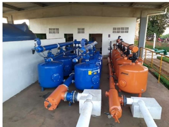
FIGURA 15- FILTROS DO SISTEMA DO GOTEJO
