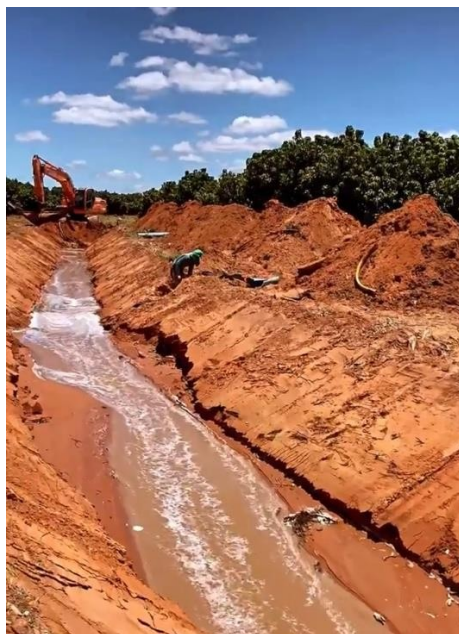
Fig3. Abertura de dreno coletor
