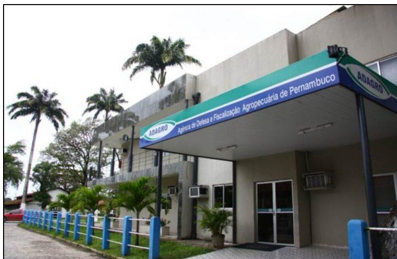
Figura 01. Fachada da Sede da ADAGRO, em Recife/PE.
