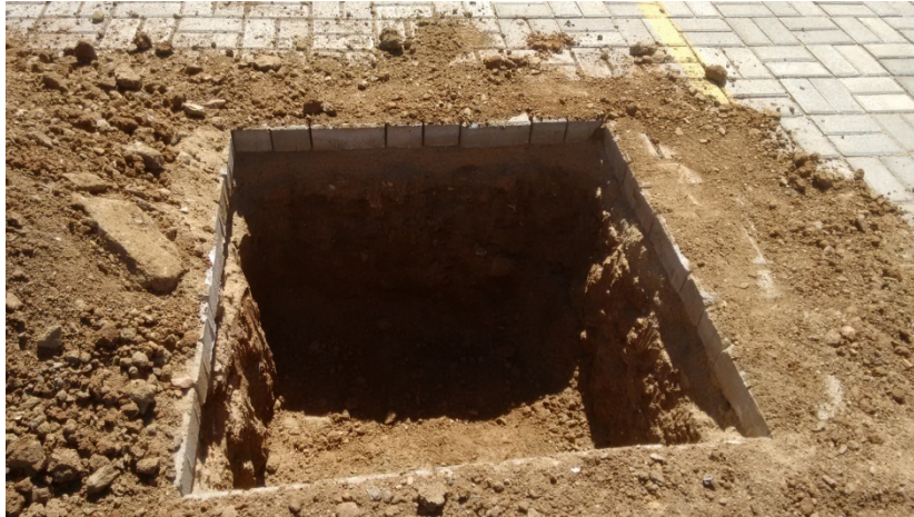
Figura 19: Preparação do canteiro. Serra Talhada/PE, 2016.
